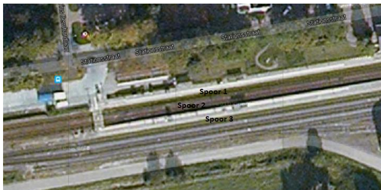
Figuur 27: Overzichtswaergave station Zuidbroek
