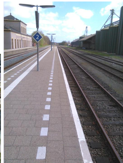
Figuur 26: Eilandperron spoor 2 en 3 station Zuidbroek
